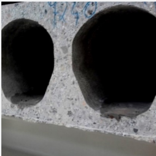
Fot. 7 Krawędzie czołowe
