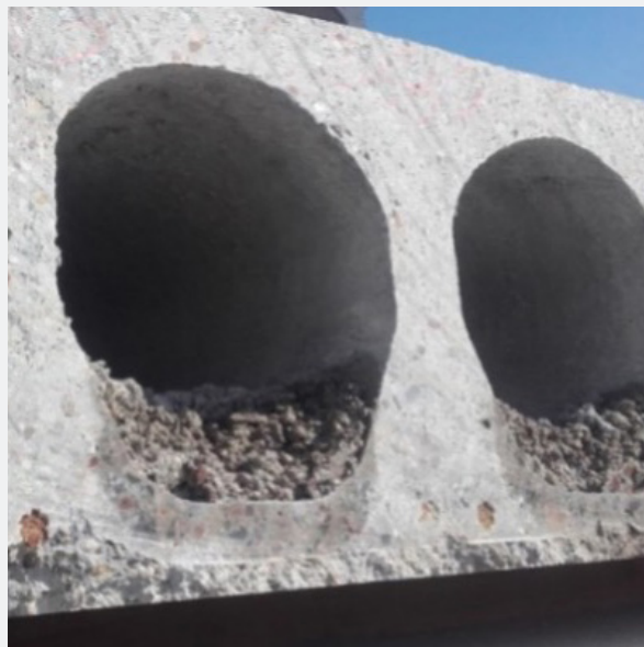
Fot. 8 Krawędzie czołowe
